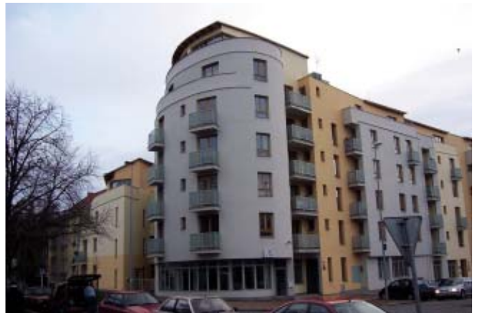
Budova kanceláří SPLDD
